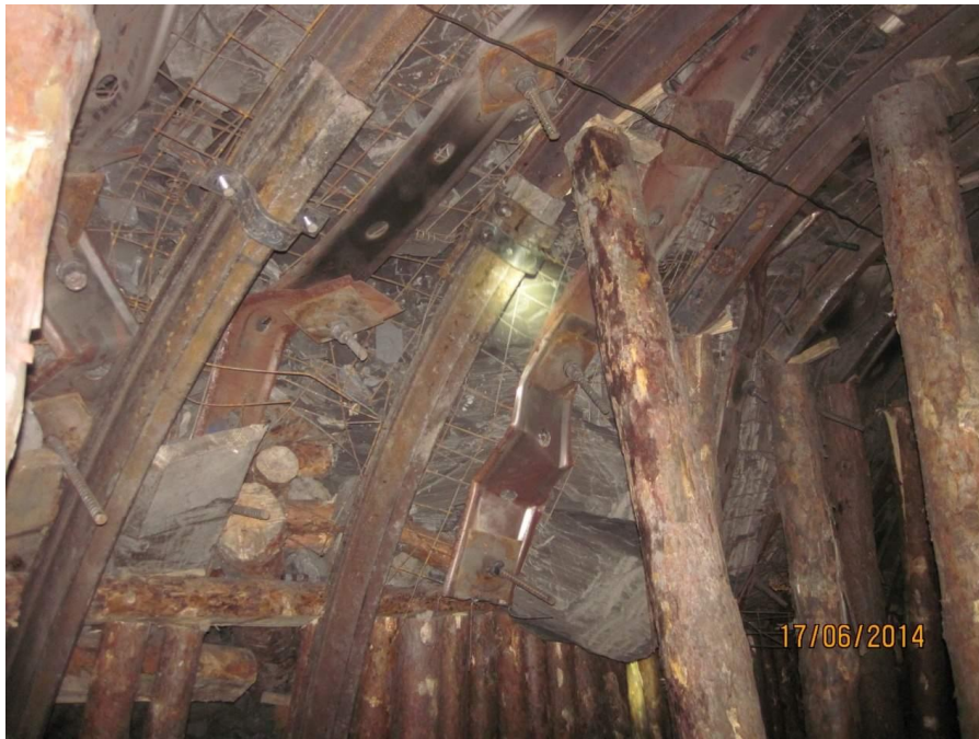
Рисунок 2.16 – Деформации металлических прогонов на ПК180 выдавливание разрушенных пород в боках выработки
