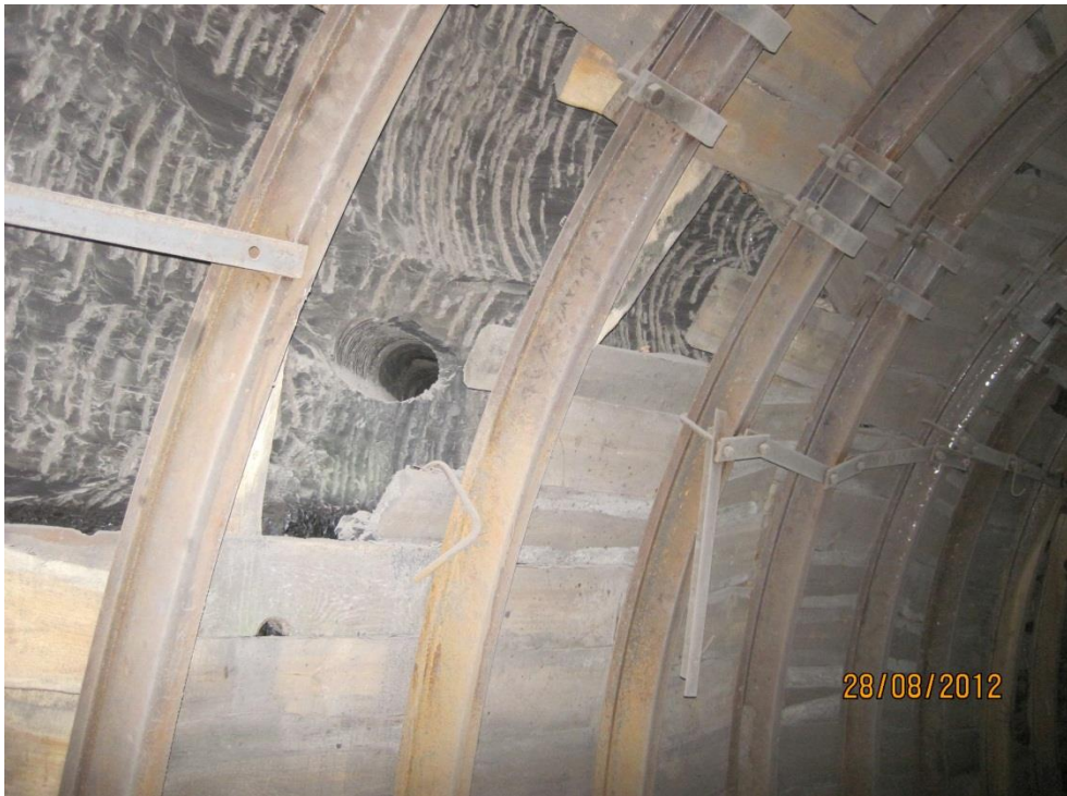
Рисунок 2.61 – Устье скважины, пробуренной для прокола
