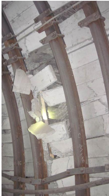
Рисунок 4.40 – Состояние железобетонной затяжки на участке без тампонажа
