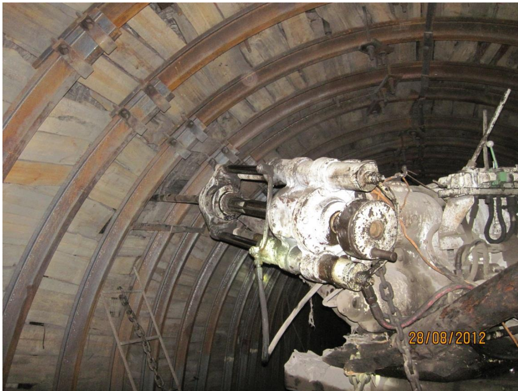
Рисунок 2.60 – Буровая установка выполняет бурение скважины под проколот
