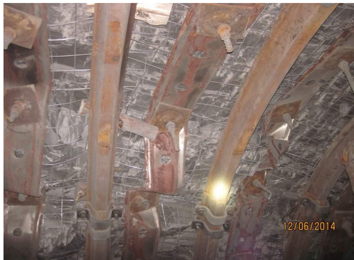
Рисунок 2.15 – ПК 180 складывание анкерных подхватов «гармошкой»
